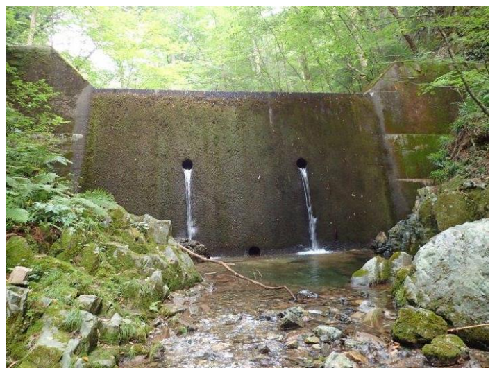
大泣きしているような砂防堤 12:21 この先が終了点
