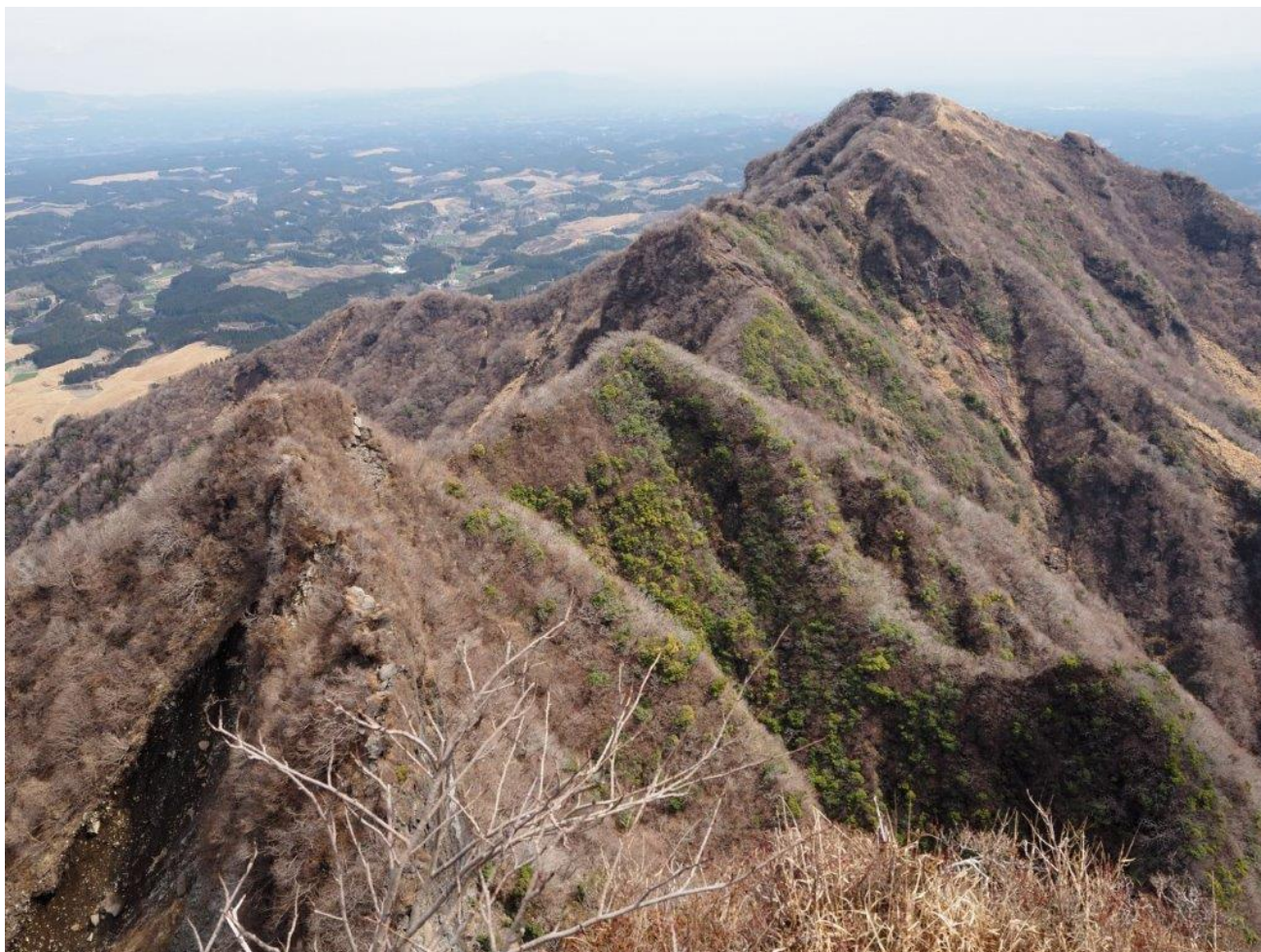
2022 年 4 月今回撮影 天狗峰より東峰を望む〔画面左下の岩場が、崩壊して確認できない〕
