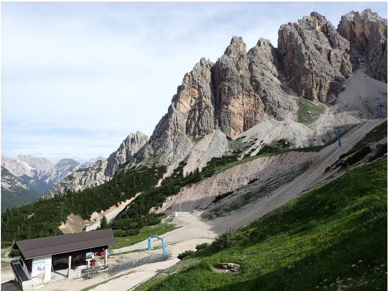
リフト下車後のロッジから〔この二区間目のリフトが、全く稼働してなかった〕
